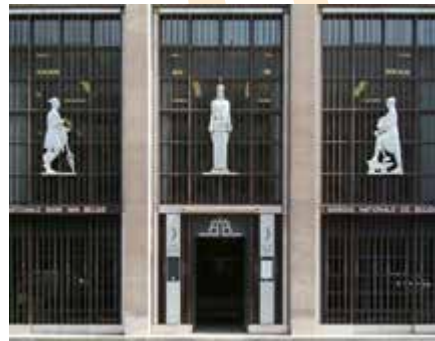
Sculptures en aluminium au-dessus de l'entrée principale de la Banque nationale © Musée de la Banque nationale de Belgique
